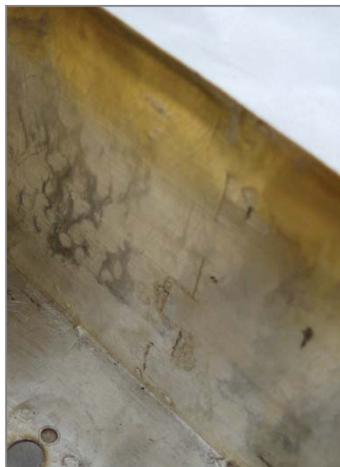
Verzahnte Blechverbindung an der Zarge
